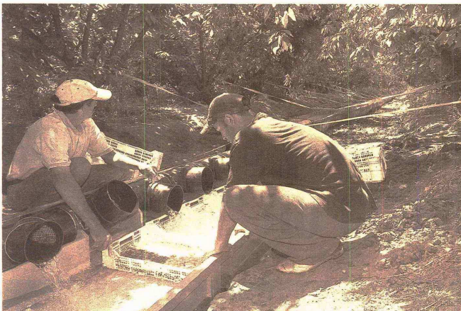
"FSH Flume System for Harvesting", de la Sociedad Agrícola El Nectarín Ltda. Aumenta el rendimiento de los trabajadores durante la cosecha de cerezas (al disminuir las distancias que deben caminar).
